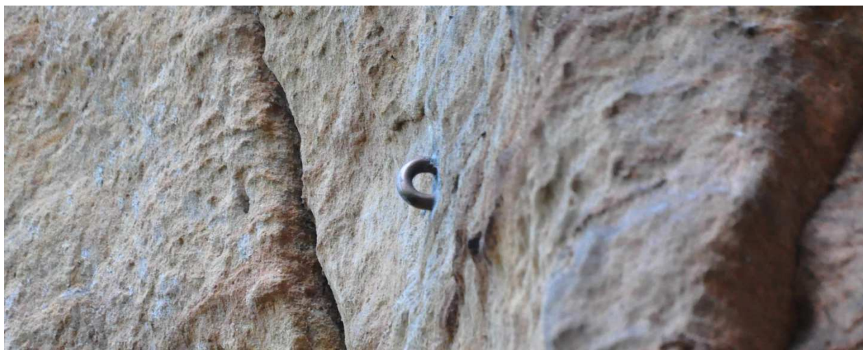
Abb.: geklebter 12-mm-Borhák, Auge 1/3 versenkt
