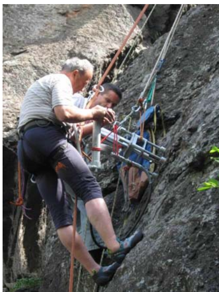
Zkouška kruhu na Kozelce
